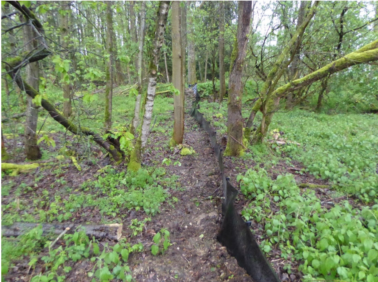
Abbildung 11: Aufgestellter Amphibienzaun um den Eingriffsbereich
