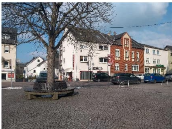
Abb. 7: Gebäudezeile entlang der Laubacher Straße
