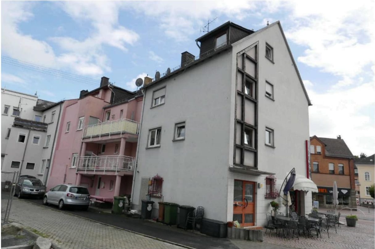
Abb. 28: Blick auf die Bestandsbebauung im Südosten des Plangebiets
