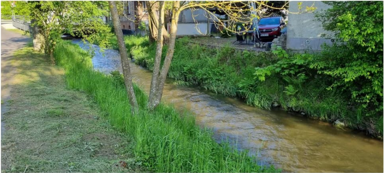
Foto 9: Gebäude und Stellfläche im unmittelbaren Uferbereich des Saynbaches, das nach Rücknahme der Baufläche im B-Plan beseitigt würde.
