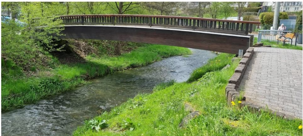
Foto 1: Begradigter Gewässerverlauf des Saynbaches innerhalb der Ortslage von Selters mit punktuellen Uferbefestigungen
