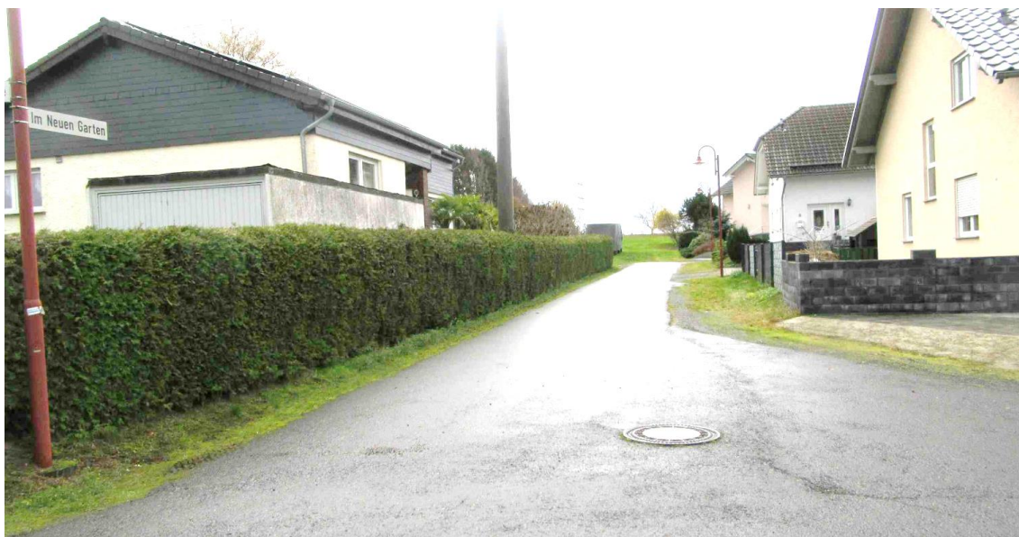
Abb. 6: Ausbaustand der Straße „Im Neuen Garten“
