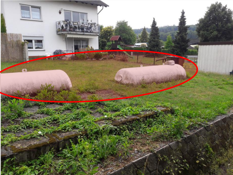
Abbildungen 23 und 24: Gastanks, „Am Tannenhain 1“, Ellenhausen (Quelle: G3i Kommunale Infrastruktur GmbH)
