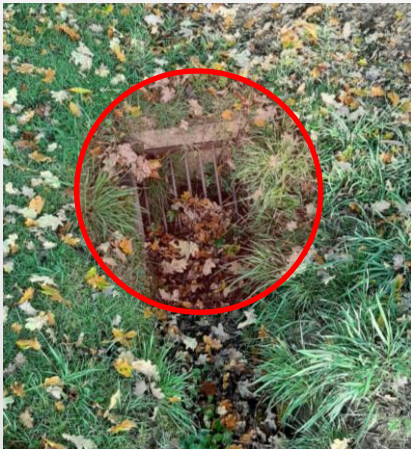
Einlauf in Verrohrung
