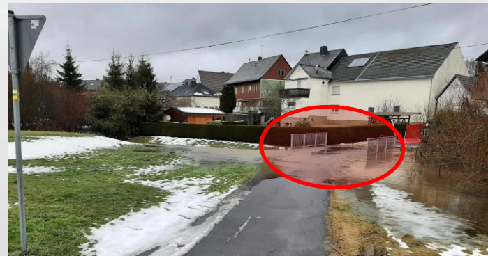
Abbildung 29: Durchlass im Hochwasserfall 29.01.2021, „Namenloses Gewässer“ Wölferlingen (Quelle: GBi Kommunale Infrastruktur GmbH)
