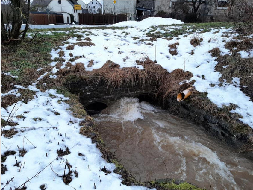
Abbildung 23: Durchlass „Namenloses Gewässer“ unterhalb der „Freilinger Straße“, Wölfelingen (Quelle: G3i Kommunale Infrastruktur GmbH)
