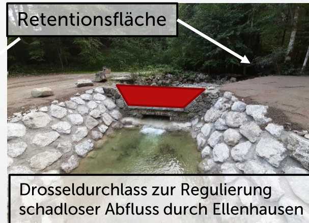
Abbildung 16: Ausführungsmöglichkeit Drosselbauwerk (Quelle: GBi Kommunale Infrastruktur GmbH)
