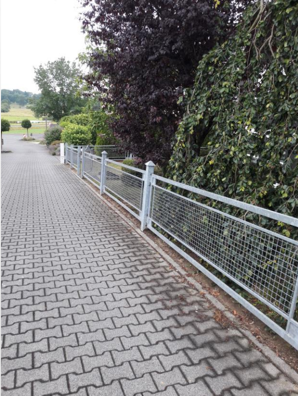
Abbildung 13: Grundstückseinfassung „Am Tannenhain 24“, Ellenhausen (Quelle: GBi Kommunale Infrastruktur GmbH)
