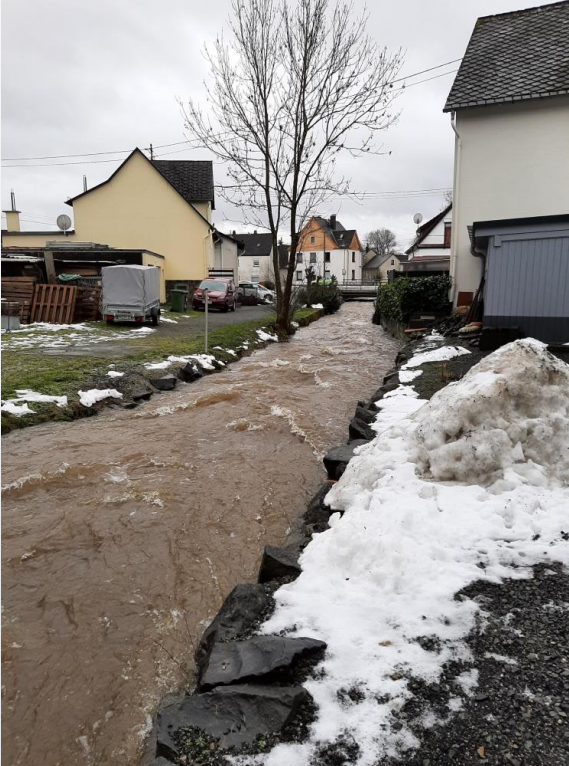
Abbildung 17: Uferbefestigung „Saynbach“, Freilingen (Quelle: GBi Kommunale Infrastruktur GmbH)
