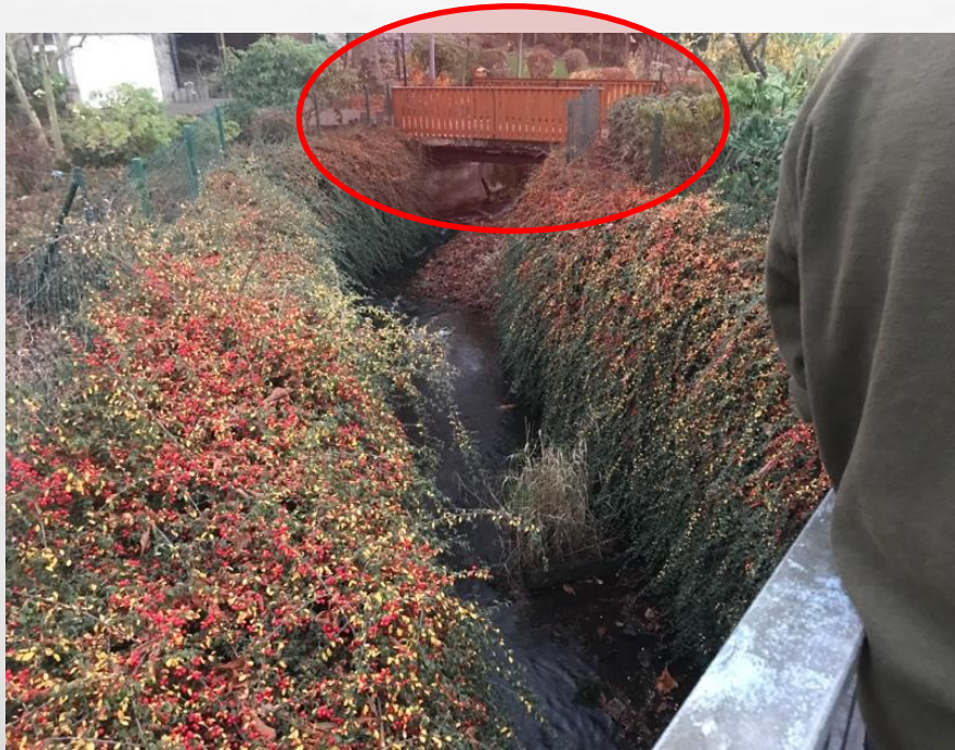
Abbildung 16: „Saynbach“, „Mühlenweg“ Freilingen (Quelle: GBi Kommunale Infrastruktur GmbH)
