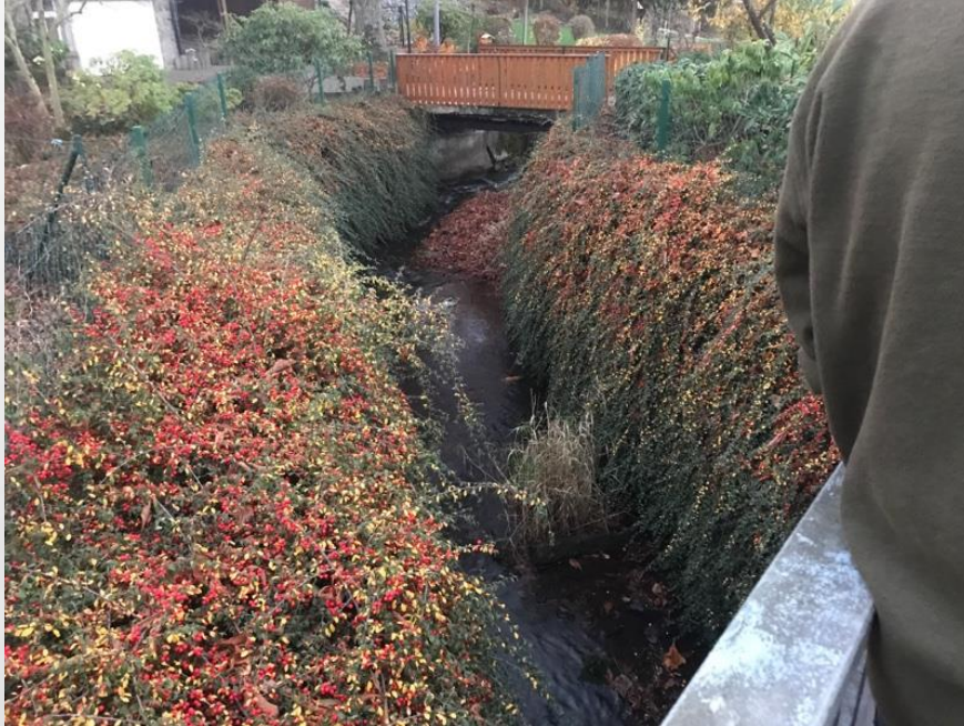
Abbildung 15: „Saynbach“, „Mühlenweg“ Freilingen (Quelle: GBi Kommunale Infrastruktur GmbH)
