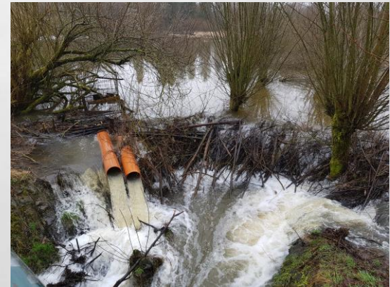
Abbildungen 5 bis 8: Gefährdungsbereiche Freilingen (Quelle: G3i Kommunale Infrastruktur GmbH)
