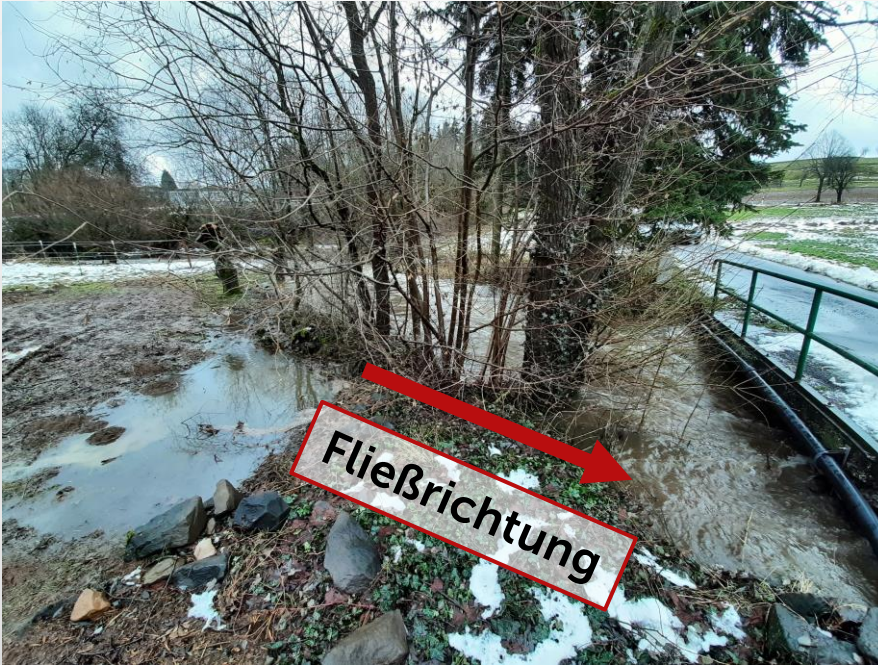
Abbildung 21: Brücke „Saynbach“, Verlängerung „Talweg“ Freilingen (Quelle: GBi Kommunale Infrastruktur GmbH)
