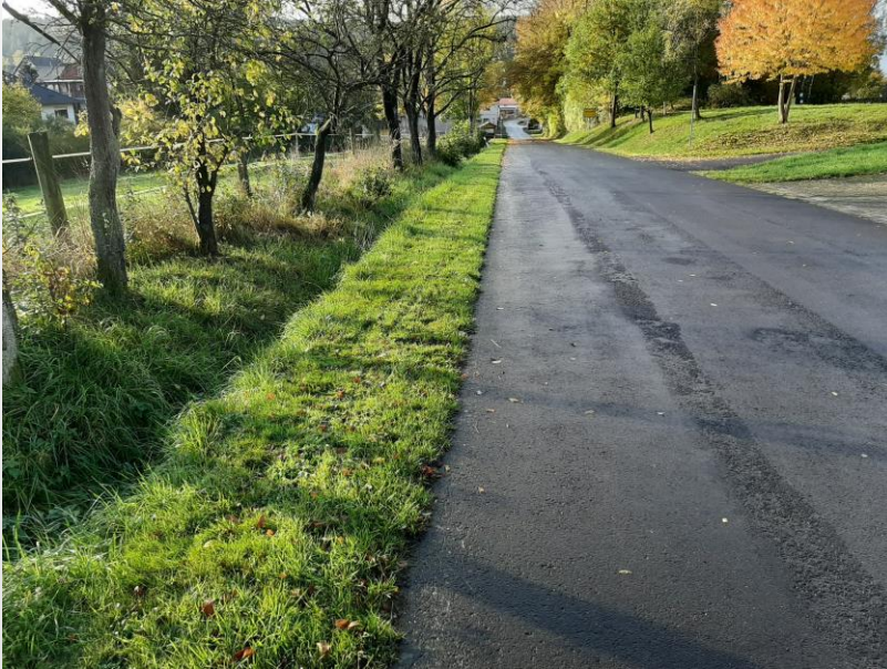
Abbildung 30: Gräben der Straßenentwässerung entlang „Zum Acker“, Freirachdorf (Quelle: GBi Kommunale Infrastruktur GmbH)
