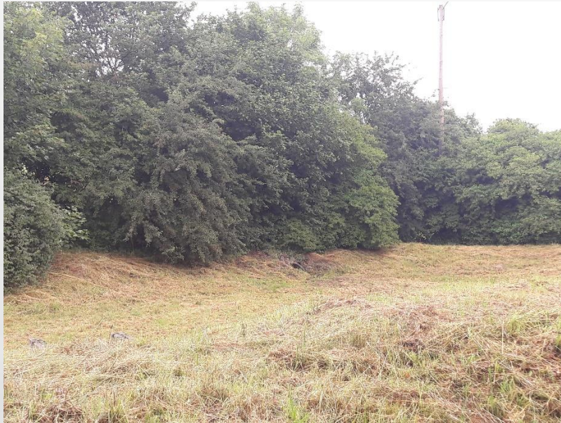
Abbildungen 13: Regenrückhaltebecken zur Entwässerung des Neubaugebietes Freirachdorf (Quelle: G3i Kommunale Infrastruktur GmbH)
