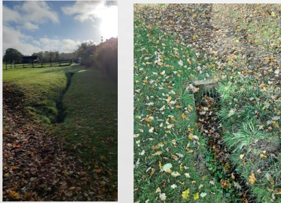
Abbildungen 25 bis 27: Notwasserweg entlang des nördlichen Außengebietes, Freirachdorf (Quelle: G3i Kommunale Infrastruktur GmbH)
