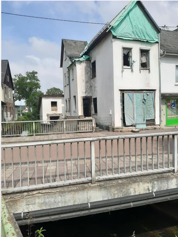
Abbildung 25: „Hauptstraße 1“, Herschbach (Quelle: GBi Kommunale Infrastruktur GmbH)
