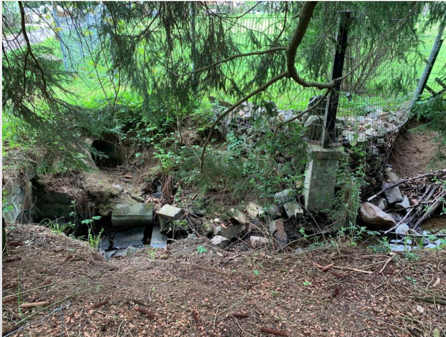
Abbildung 12: „Viehbachgraben“, Herschbach (Quelle: GBi Kommunale Infrastruktur GmbH)
