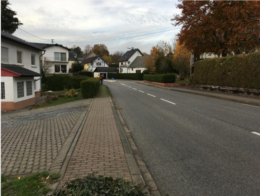
Abbildung 30: „Hauptstraße“, Krümmel (Quelle: G3i Kommunale Infrastruktur GmbH)
