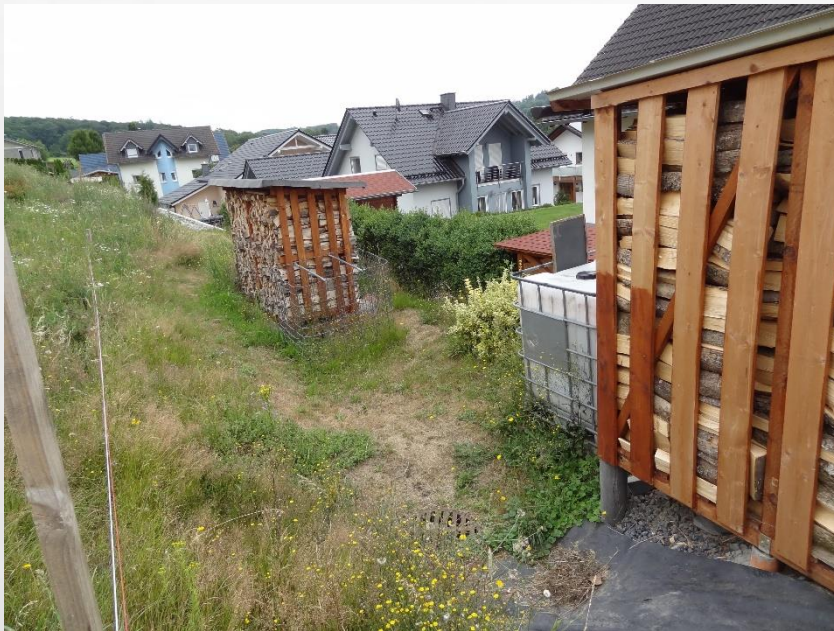
Abbildung 49: Retentionsmulde, Bebauung „Rotherde“ Maxsain (Quelle: G3i Kommunale Infrastruktur GmbH)
