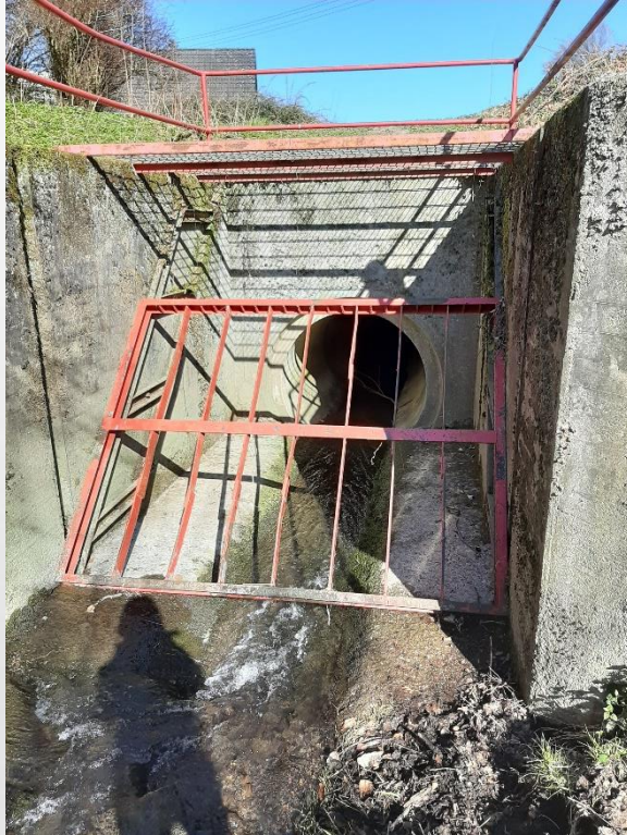
Abbildung 30: Einlauf Verrohrung „Steinchesbach“ (Quelle: G3i Kommunale Infrastruktur GmbH)
