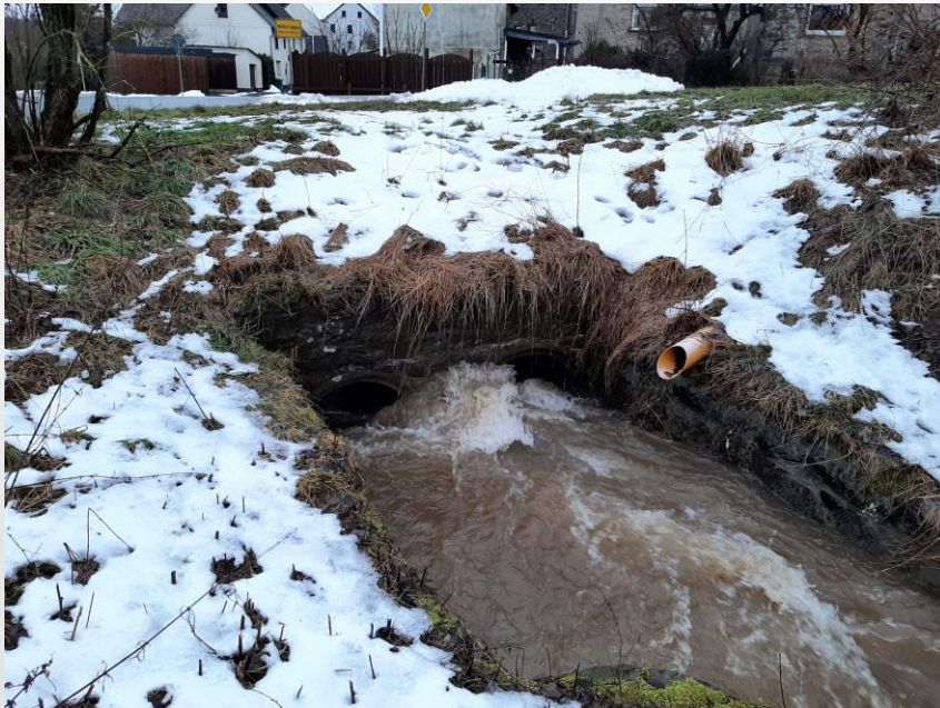
Abbildung 23: Durchlass „Namenloses Gewässer“ unterhalb der „Freilinger Straße“, Wölferlingen (Quelle: GBi Kommunale Infrastruktur GmbH)
